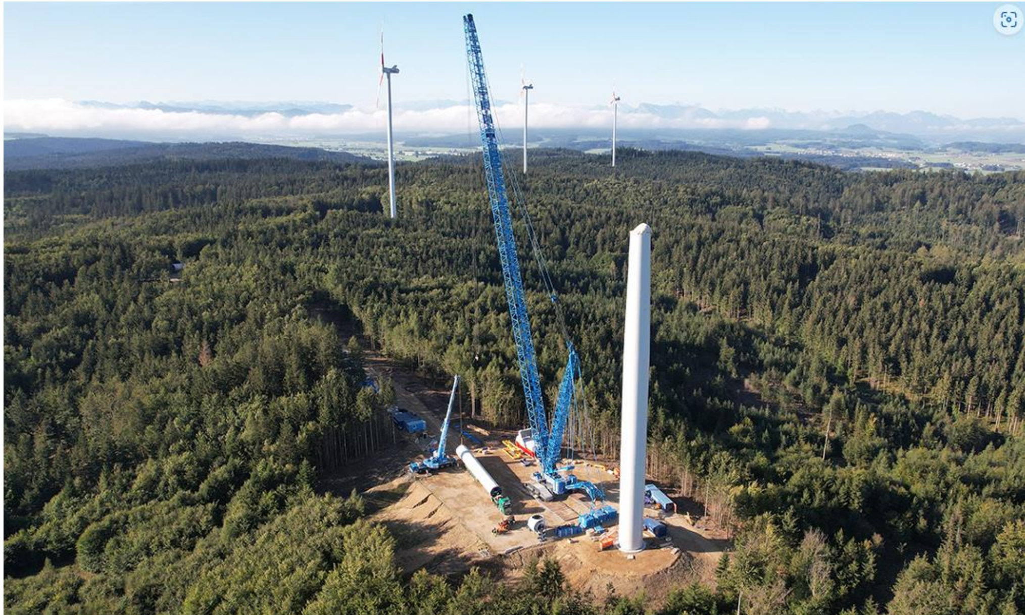
Antransport und Aufbau Hybrid-Stahlurm
