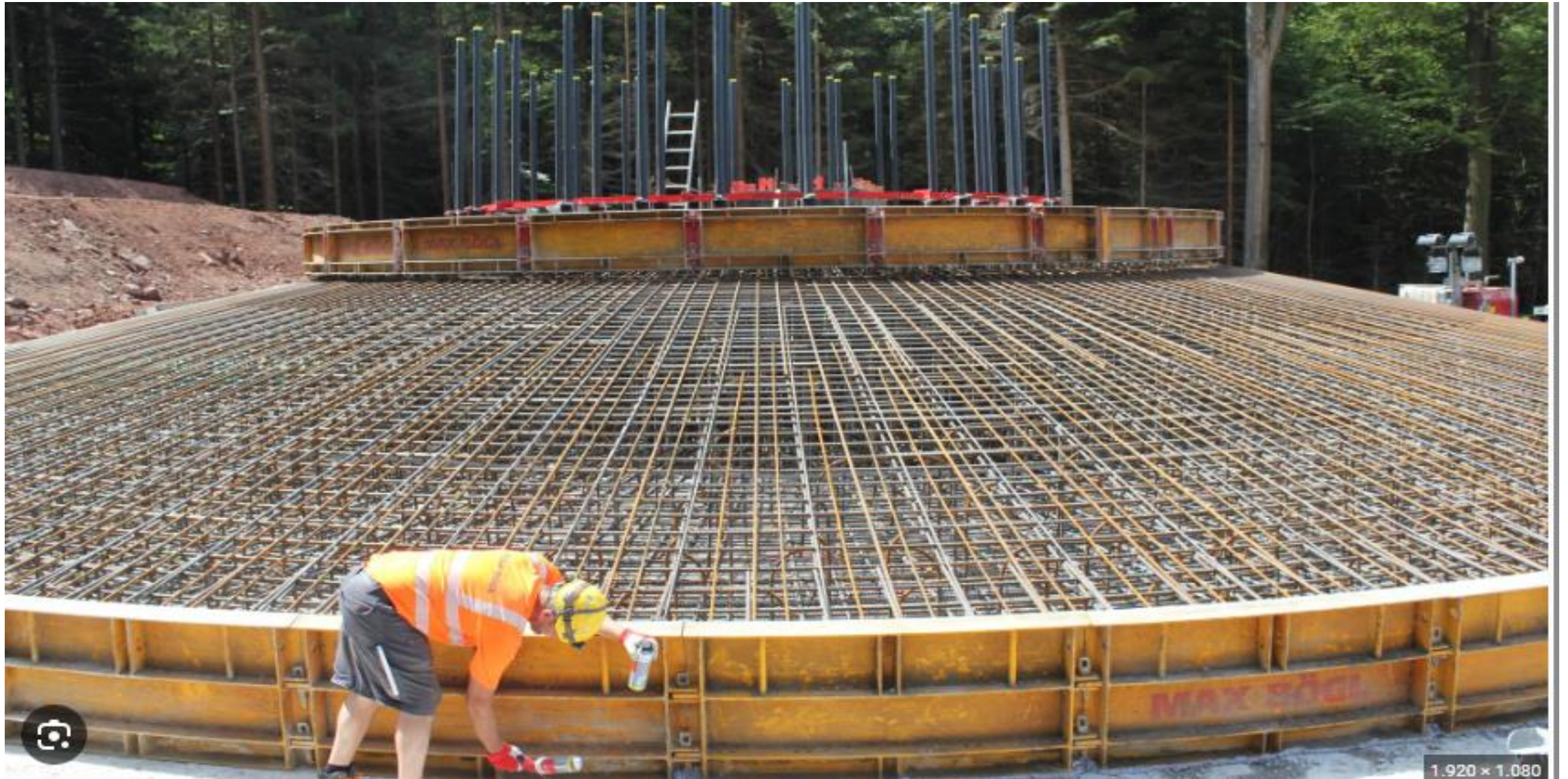
Fundament, Durchmesser 25 m1
