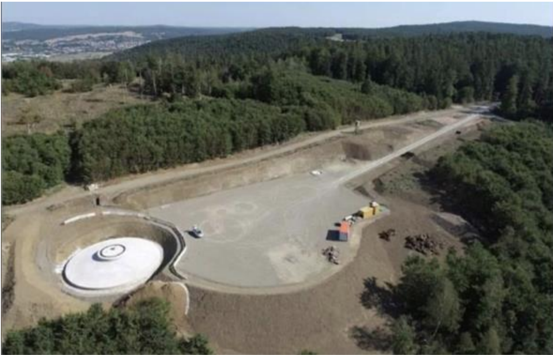
Baustellen - Installationsplatz im Wald
